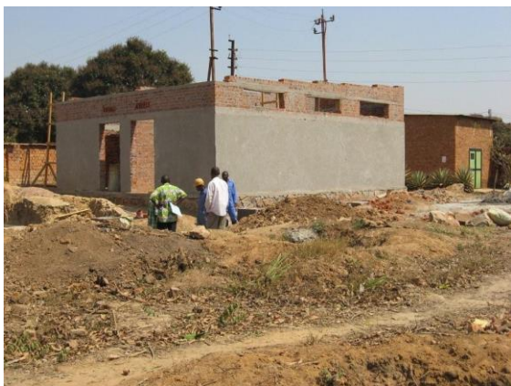
Klaslokaal in aanbouw
